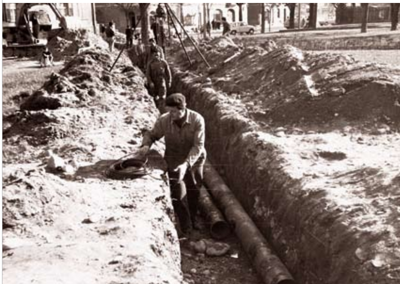
Bau des »Tambosi«-Tiefbrunnens (1962)
