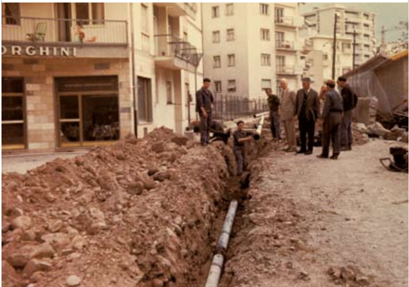
Verlegung der Trinkwasserleitung im Mariaheimweg (1965)
