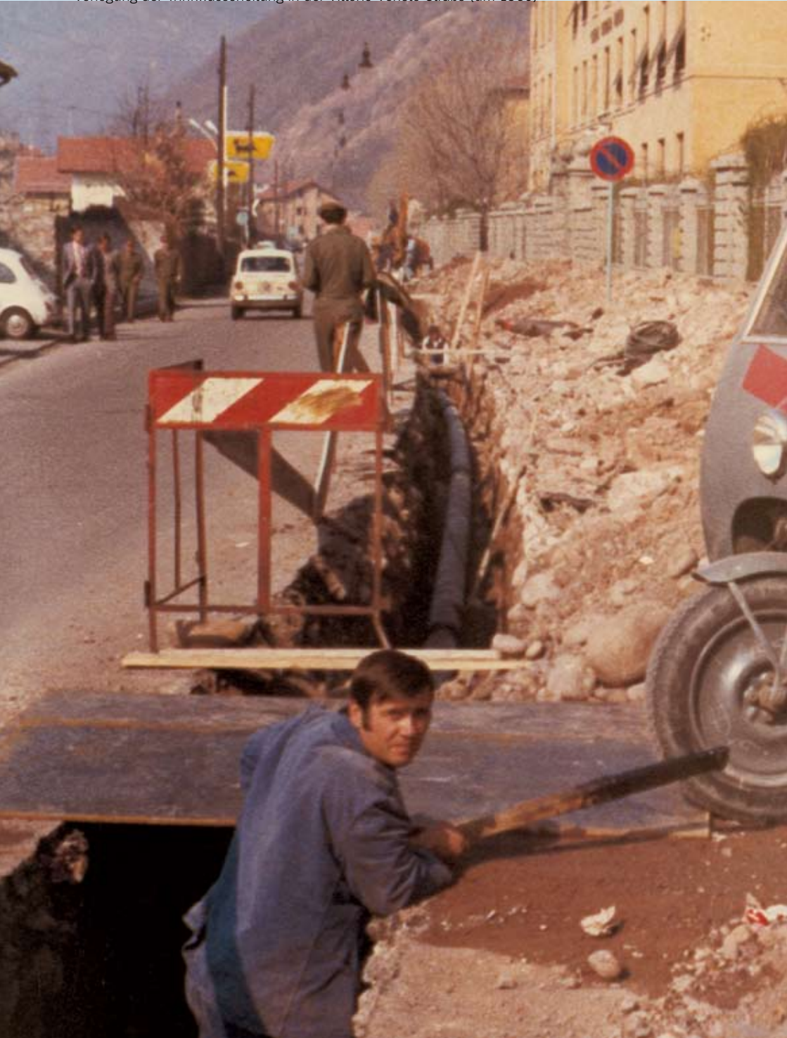
Verlegung der Trinkwasserleitung in der Vittorio-Veneto-Straße (um 1960)
