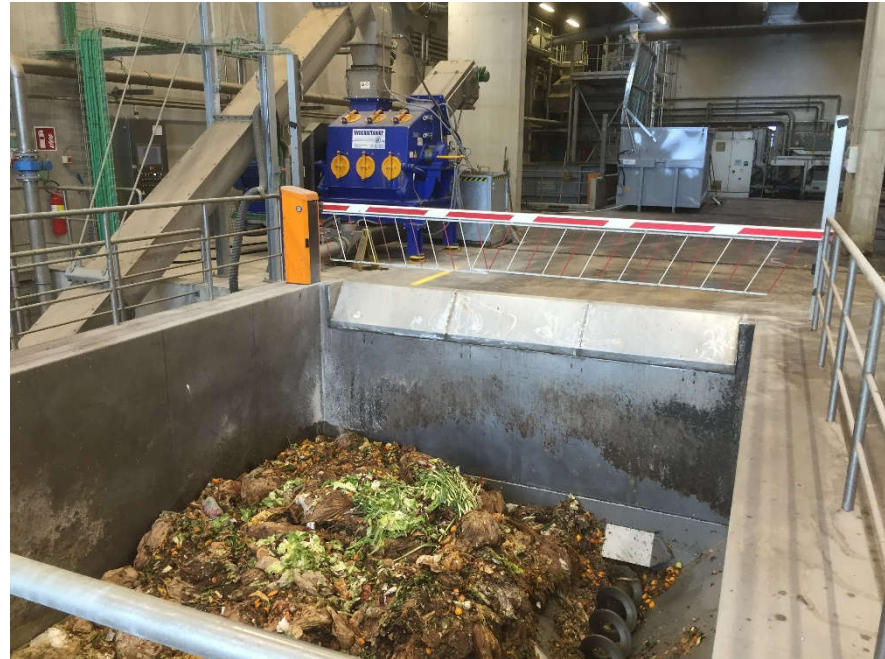
bunker di stoccaggio
