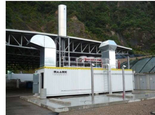
Cogeneratore 2 P= 536 KWe
