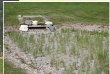
Versickerungsmulde neben Teichanlage
