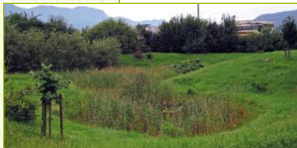
Beckenversickerung bei der Autobahnausfahrt Bozen Süd
