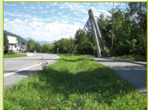
Muldenversickerung in der Industriezone Brixen
