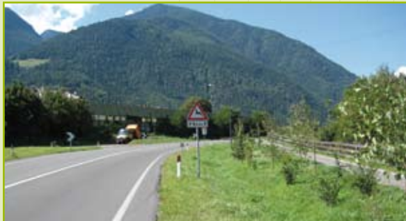
Muldenversickerung entlang der Brennerstraße in Vahrn
