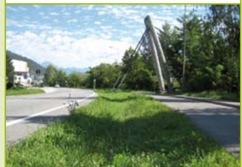
Fosso d'infiltrazione in zona industriale a Bressanone
