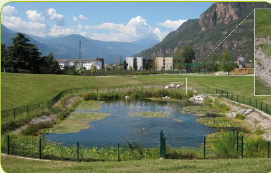
Bacino di ritenzione presso la zona residenziale Firmian, Bolzano
