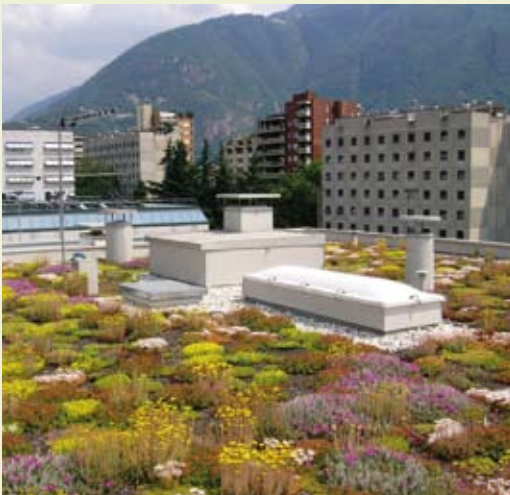
Inverdimento estensivo sul tetto dell'Istituto per l'edilizia sociale in Via Druso, Bolzano (foto geom. Diego del Monego)
