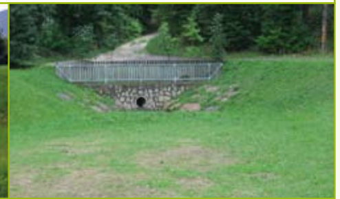
Bacino d'infiltrazione a Pianizza di Sopra, Caldaro
