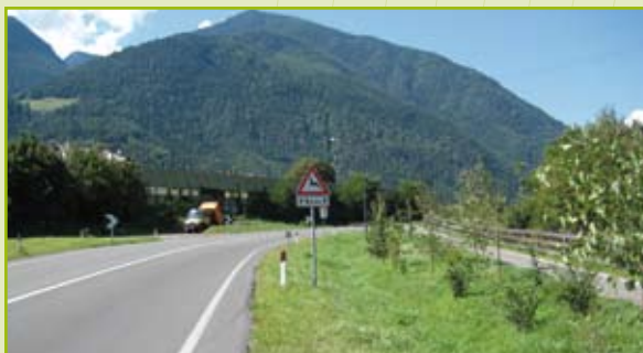
Fosso d'infiltrazione lungo via Brennero a Varna
